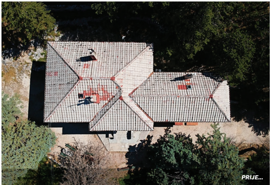
POSTAVLJANJE NOVE PLOČE
