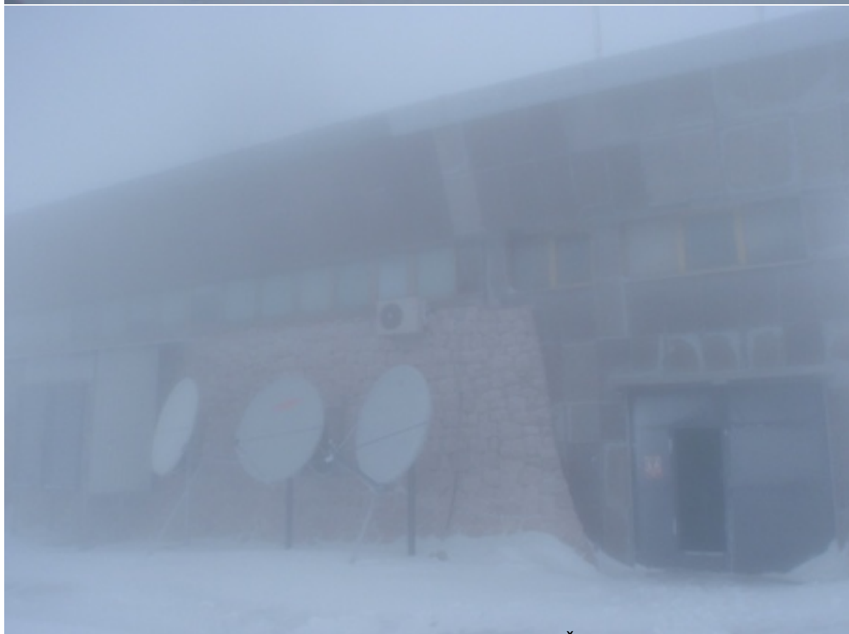
Spomenik na vrhu Štita, izlaz iz podzemne garaže u Kopačkom jezeru. Štiti se izlazi popali Pšidovianji Tamo
